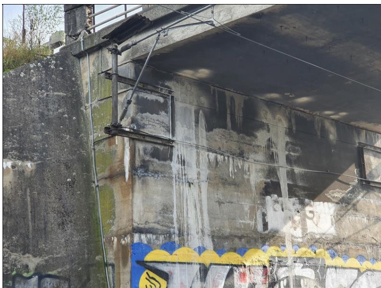
Zatékání z úl.prahu
