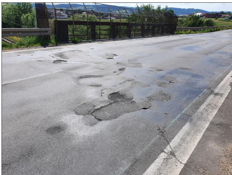
Poruchy vozovky za mostem
